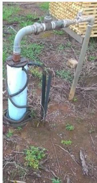
Figura 5 - Captação em poço profundo - Distrito Industrial II
